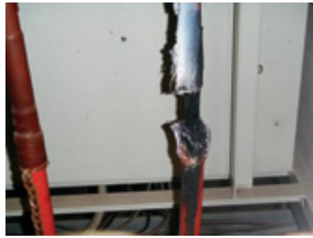
▲ **Kabelbrand durch Wassereintritt im HS-Raum der PM3 durch defekte Klimaanlage.**
